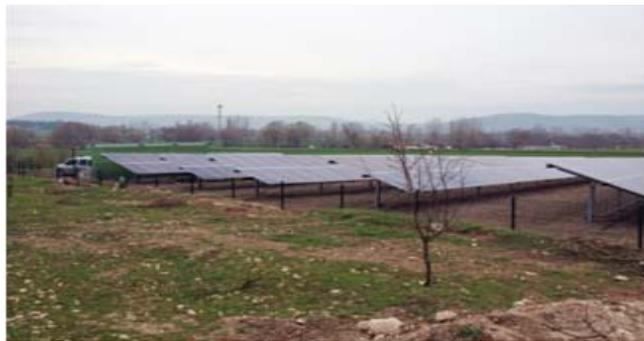
TSM-245PC05-Module mit einer Leistung von 150 kWp versorgen die Wasser-Pumpstation der Gemeinde mit Elektrizität. Auf diese Weise können die Energiekosten gesenkt werden, und der Profit beim Verkauf der landwirtschaftlichen Erzeugnisse steigt.
